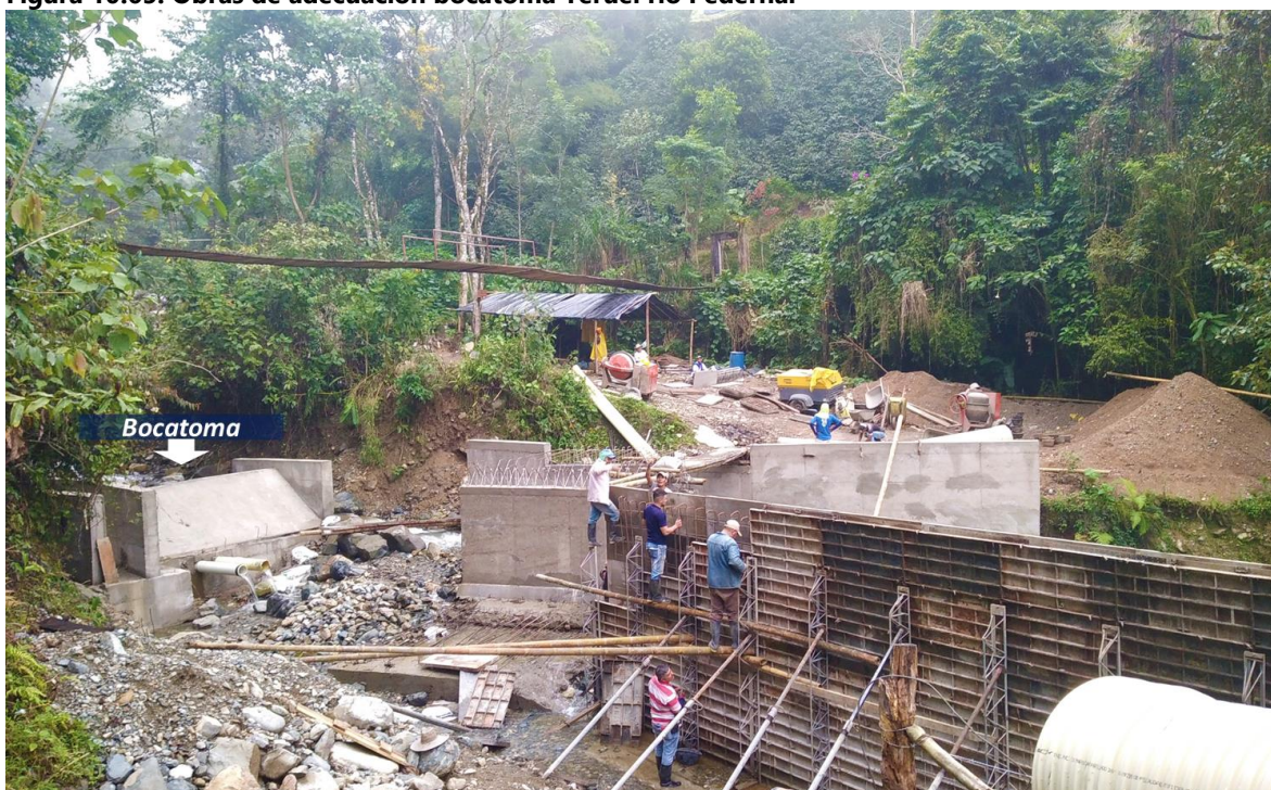
Figura 10.65. Obras de adecuación bocatoma Teruel río Pedernal
