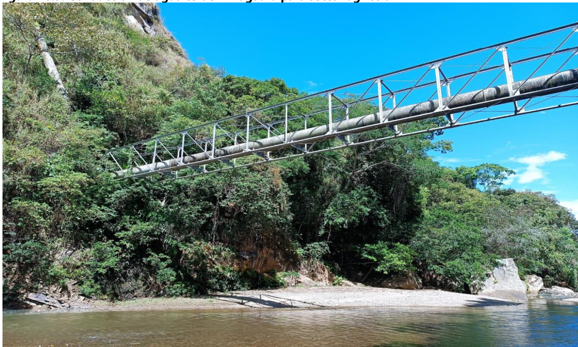
Figura 10.9. Conducción de agua teruel – Yaguará para sector agrícola
