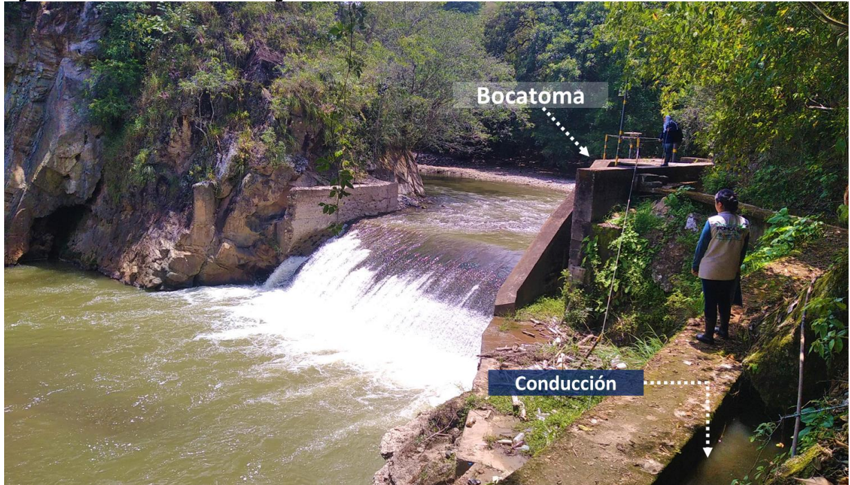
Figura 10.18. Bocatoma distrito riego sobre río Pedernal
